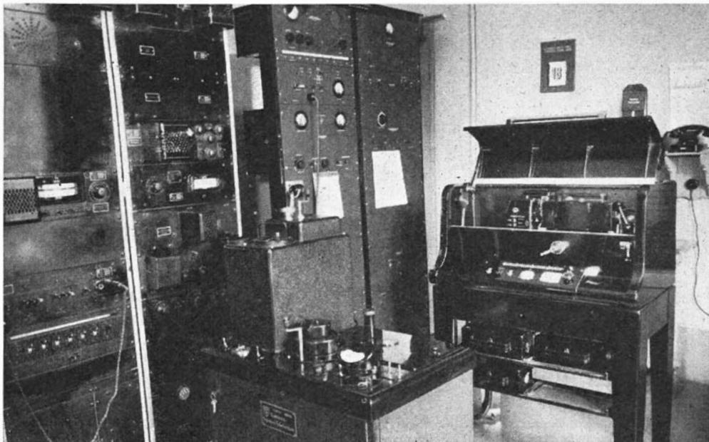
Queste sono invece le macchine riceventi telegrafiche: collegate con un filo telefonico o per radio all'apparecchio trasmittente che abbiamo visto nella vignetta precedente, ricevono immagini da ogni distanza, anche di migliaia di chilometri. Quello che osservate a sinistra è il primo apparecchio telegrafico installato in un giornale italiano, nel 1934. A destra, invece, la macchina più recente e perfezionata, ultima espressione della tecnica delle trasmissioni telegrafiche.
